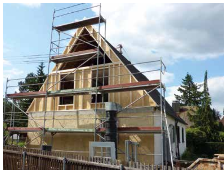
Ansicht Süd: neuer Giebel in Holzrahmenbauweise
