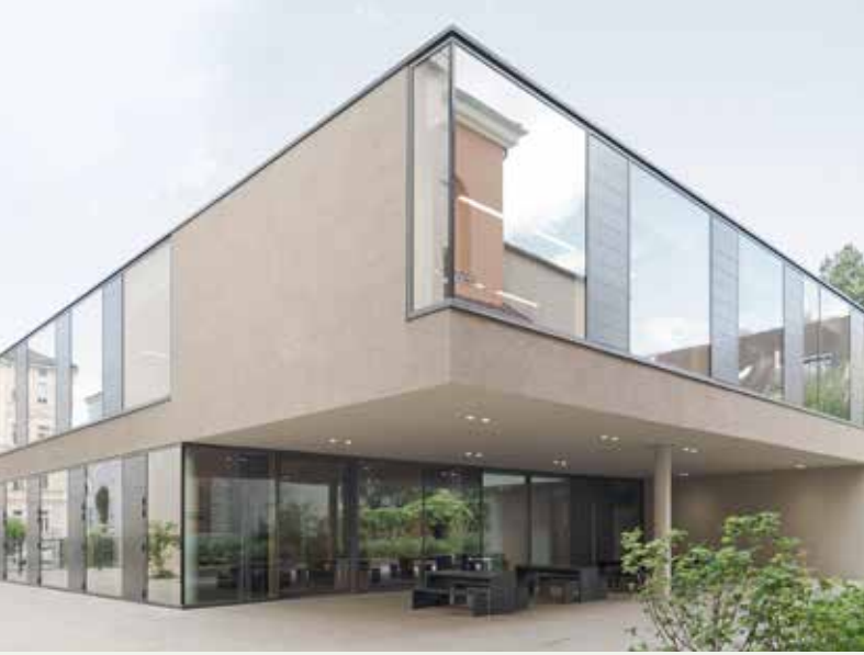
Wittelsbacher Schule Augsburg Die Schüler nennen den Neubau „Auer Haus“ frei nach dem Song „our house in the middle of the street“ | Foto Brigida González, Stuttgart
