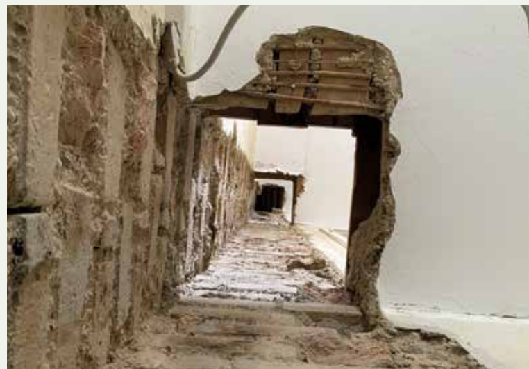
Die ersten Sanierungsmaßnahmen: die Asbestentsorgung im Treppenhaus (o.) und die Entfernung des alten Kamins (u.)
