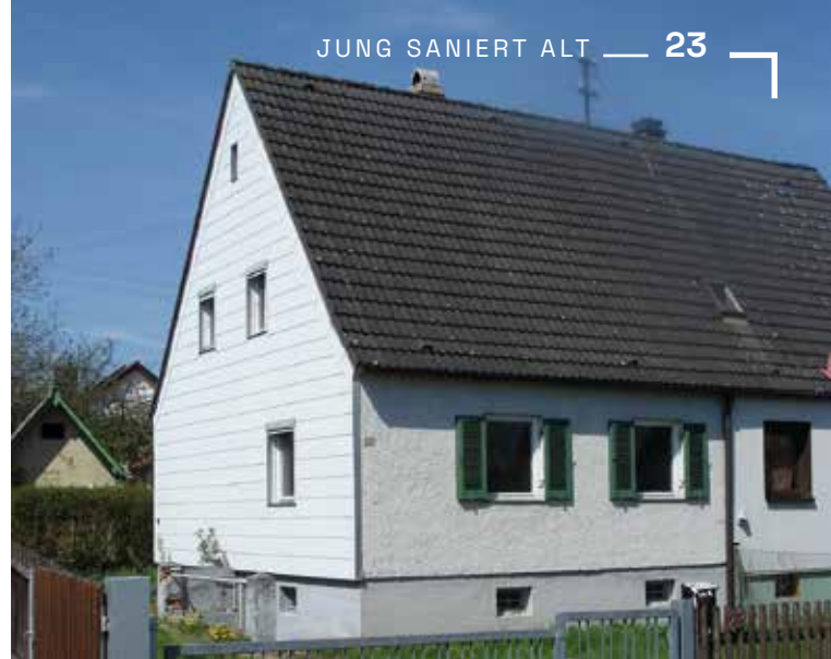
Ansicht von Süd-Ost vor der Sanierung im Jahr 2008
