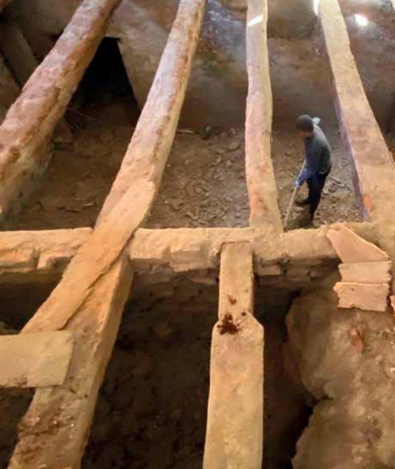
Der Bauernhof in Inningen: Blick in den Keller durch die freigelegten Balken im Boden des Erdgeschosses
