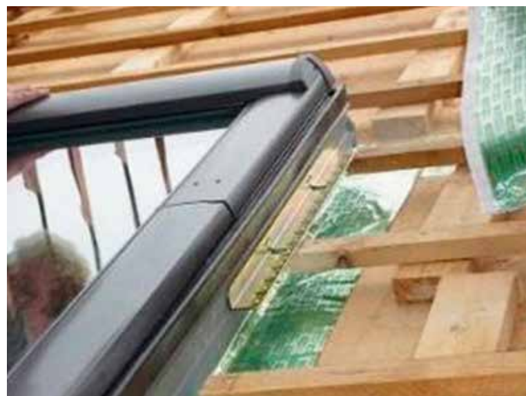
Westseite: Einbau der neuen Wohndachfenster mit 3-fach Wärmeschutzverglasung
